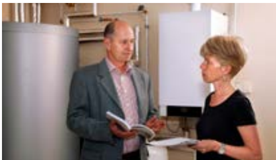
Quelle: Bundesverband der Deutschen Heizungsindustrie
