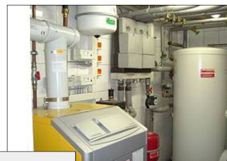
Brennwertkessel (Kleinanlage) 8 - 200 kW
