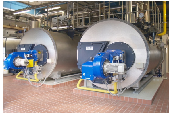
Hochdruckdampfkessel
