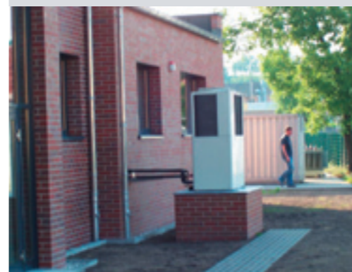
Gasklimagerät Außenheit
