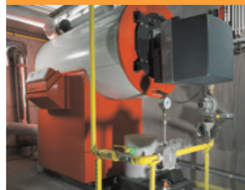
Gasbrennwertkessel
