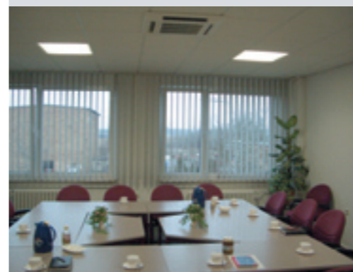
Gasklimagerät Inneneinheit
