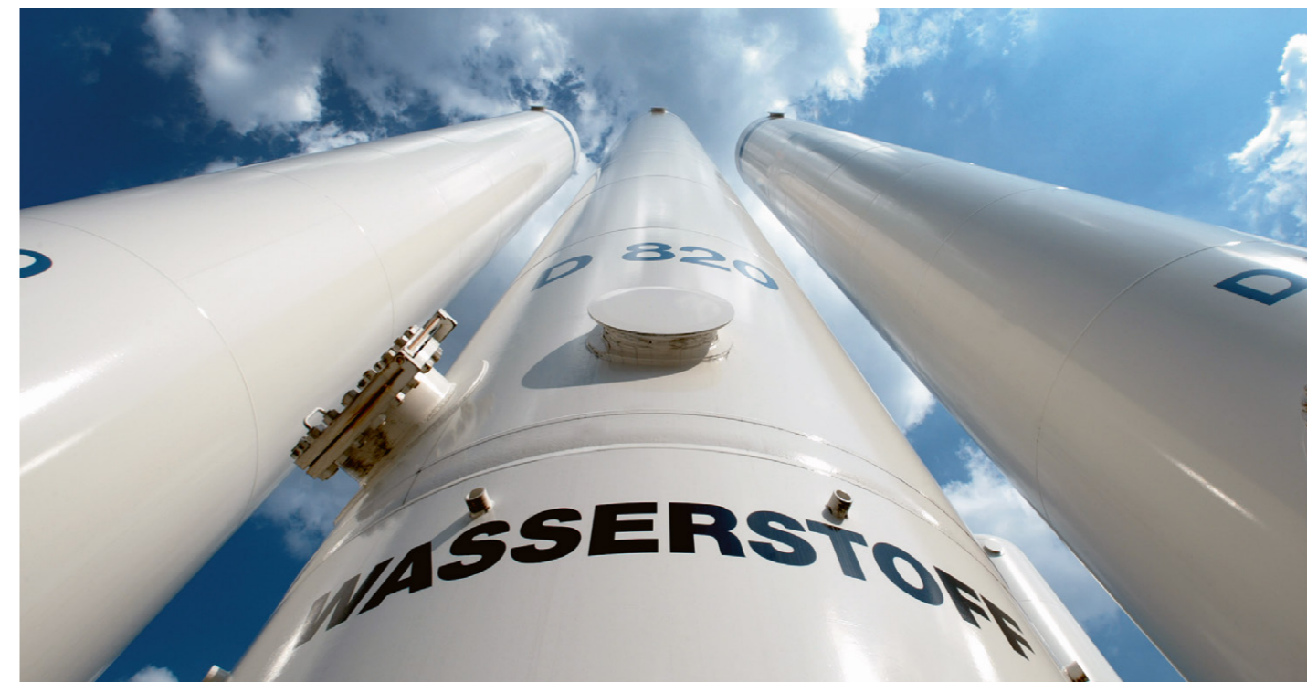
In Burghausen im bayerischen Chemiedreieck betreibt Linde mehrere Dampfreformer zur Erzeugung von Wasserstoff. | Foto: Linde AG
