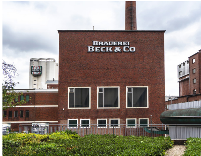
Das Kesselhaus der Brauerei an der Straße Am Deich in Bremen. | Foto: swb AG
