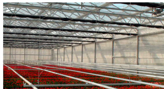
Abbildung 11: Hebesenkheizung über einer Topfpflanzenkultur, pflanzennah heruntergefahren
