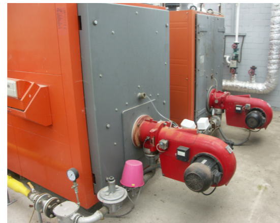
Zweikesselzentrale in einem Gartenbaubetrieb (Foto: Dipl.-Ing. Otto Domke)
