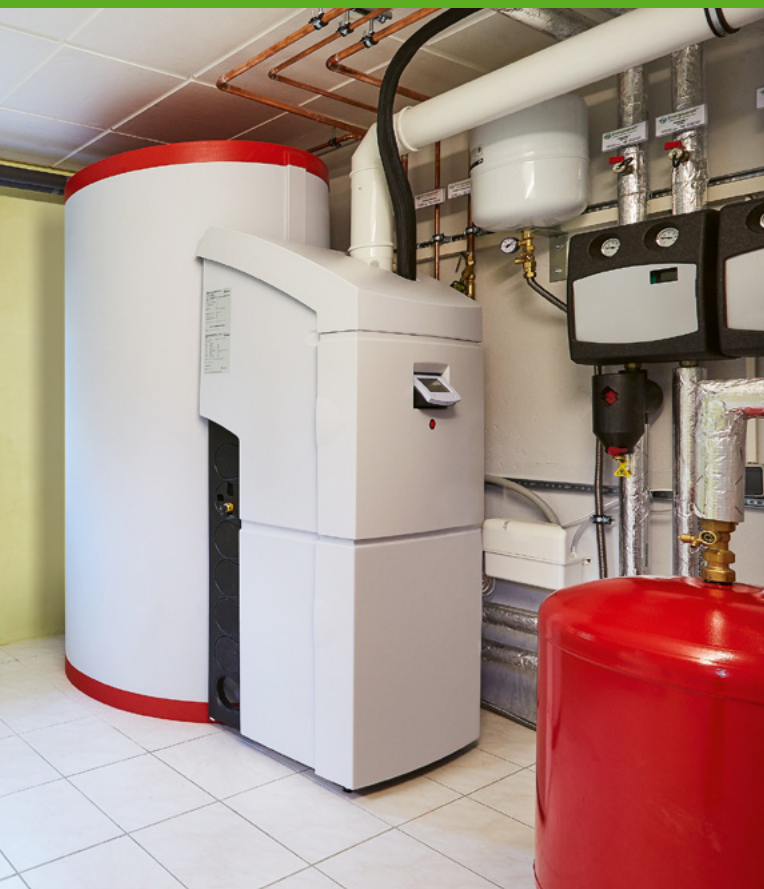
Gasheizungen lassen sich auch mit klimaneutralem Gas betreiben – heute schon mit Bio-Erdgas. Im Bild: eine moderne Gas-Brennwertheizung mit integriertem Warmwasserspeicher für die Solarthermie-Anlage
