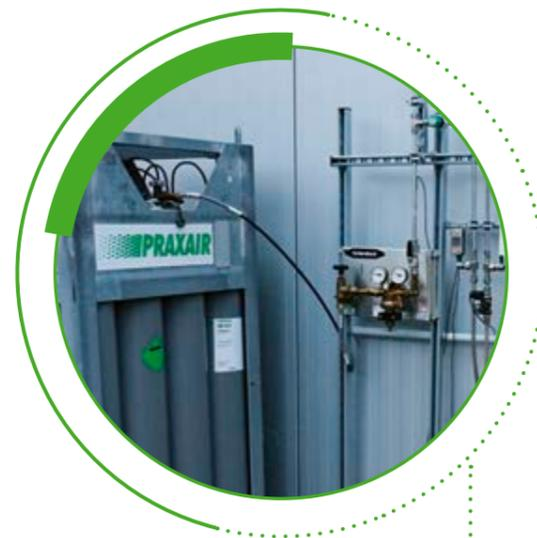
Zur Methanisierung werden dem Rieselbettreaktor in Cottbus als Reaktionsgase Kohlendioxid und Wasserstoff zugeführt. Versuche zur Methananreicherung von Biogas verliefen ebenfalls erfolgversprechend. | Foto: GICON GmbH
