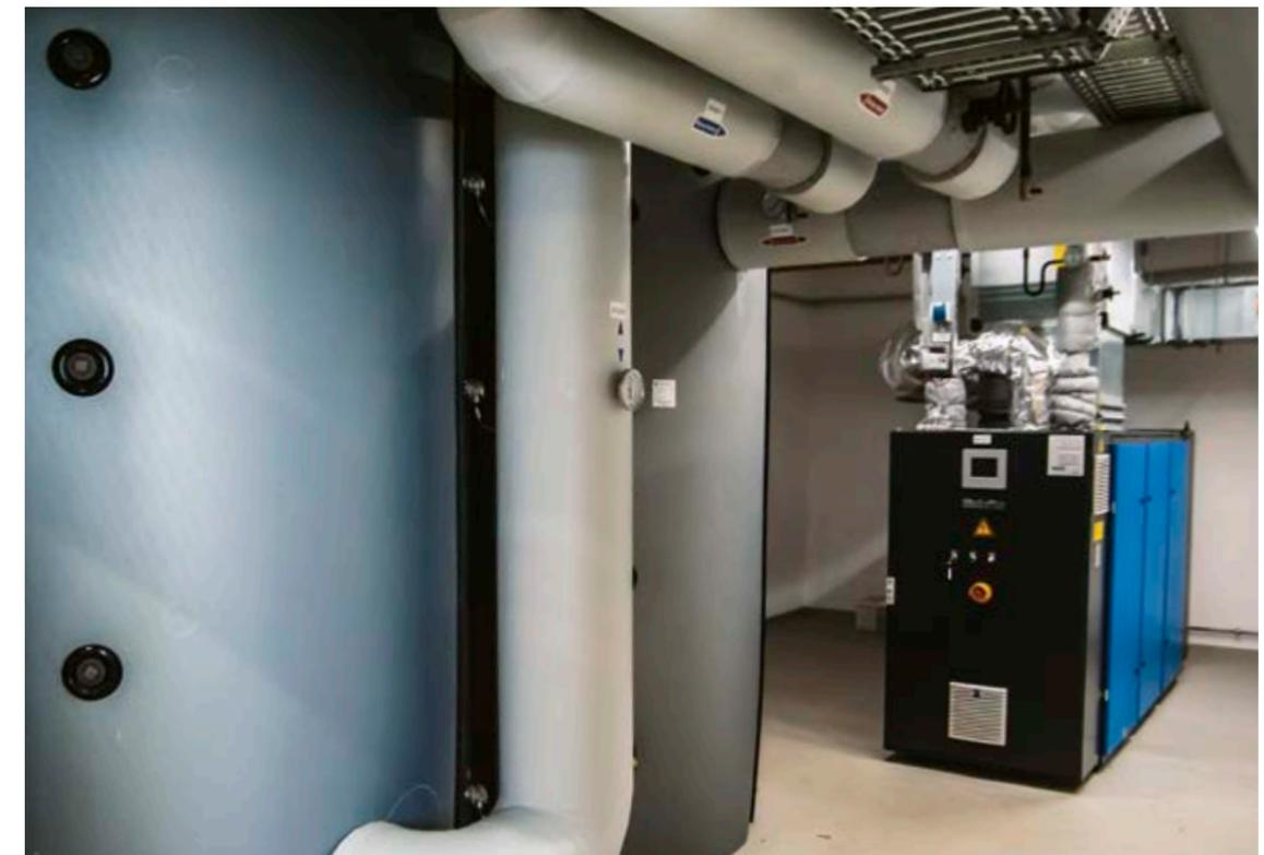
Das Blockheizkraftwerk im Keller der Silberbergschule ist unter anderem an zwei Pufferspeicher (links) gekoppelt. | Foto: Stadtwerke Geesthacht GmbH
