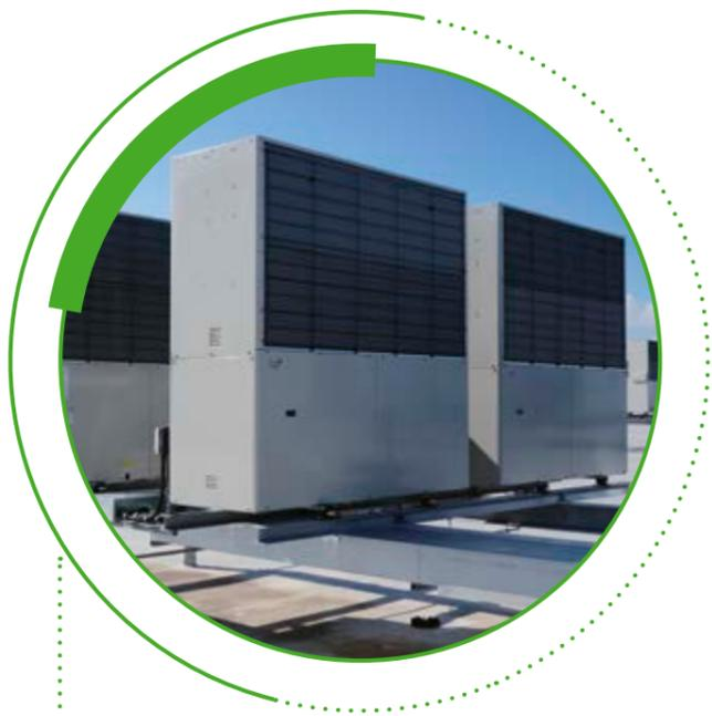
Die Gasmotorwärmepumpen bieten eine Kälteleistung von 5,5 und eine Heizleistung von 6 Megawatt. Zum Einsatz kommen außerdem 25 raumlufttechnische Anlagen mit einer integrierten Regelung, die den optimalen Betriebszustand automatisch einstellt. | Foto: KKKU CONCEPT GmbH
