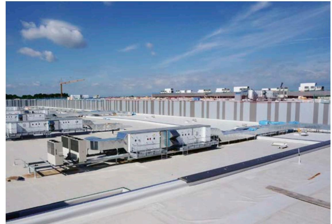
Auf dem Dach des Zalando-Logistikzentrums in Lahr im Schwarzwald verrichten 81 Gasmotorwärmepumpen ihren Dienst. | Foto: KKKU CONCEPT GmbH
