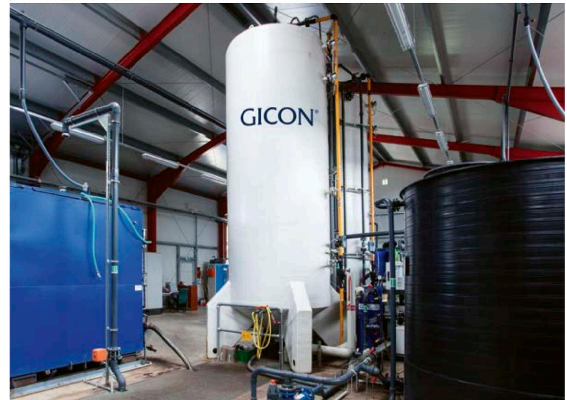
Im Versuchsreaktor in Cottbus wandeln Mikroorganismen Wasserstoff und Kohlendioxid in synthetisches Gas um, das ins Gasnetz eingespeist werden kann. | Foto: GICON GmbH
