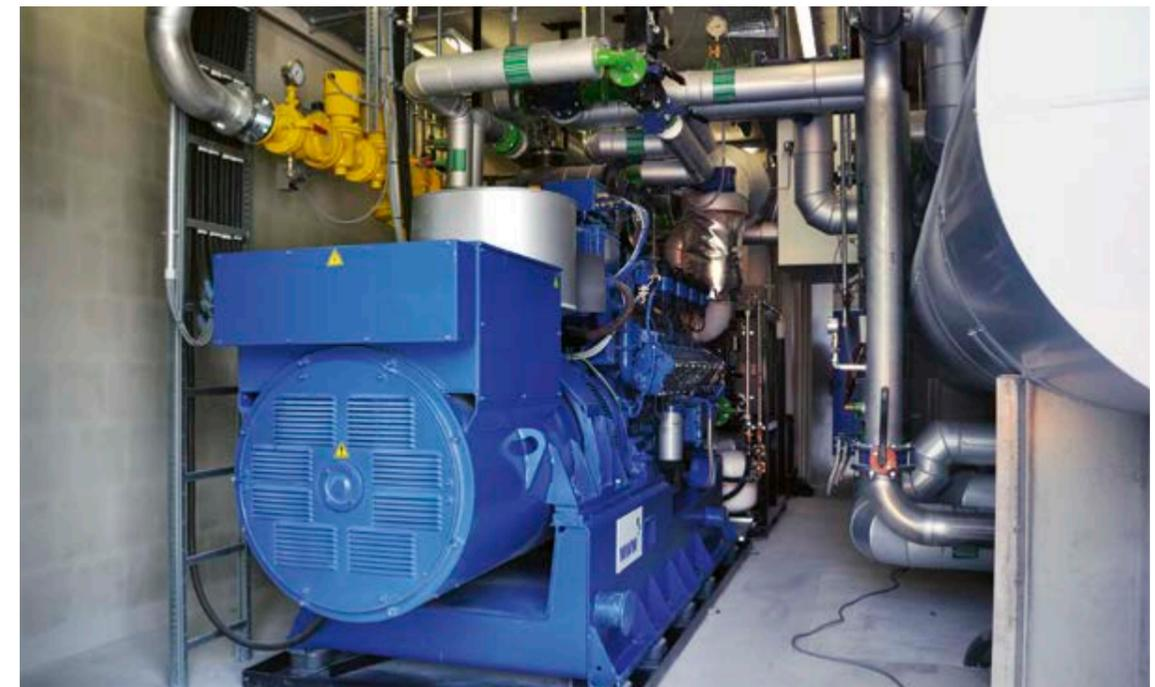
Das Blockheizkraftwerk, das in Willingen ein Hotel und mehrere kommunale Gebäude mit Wärme versorgt. | Foto: EAM EnergiePlus GmbH
