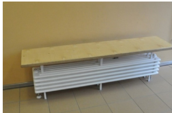
Abbildung 23: Radiator als Sitzelement
