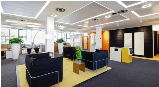
Abbildung 24: Heiz- und Kühldeckensystem in einer Bank
