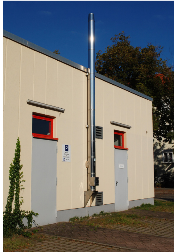
Abbildung 30: Edelstahlabgasleitung Außenwand
