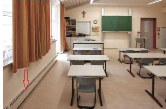
Abbildung 21: Sockelheizung in einer Schule
