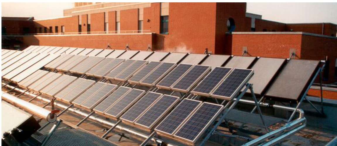
Abbildung 16: Solarthermische Anlage und zusätzliche Photovoltaikanlage
