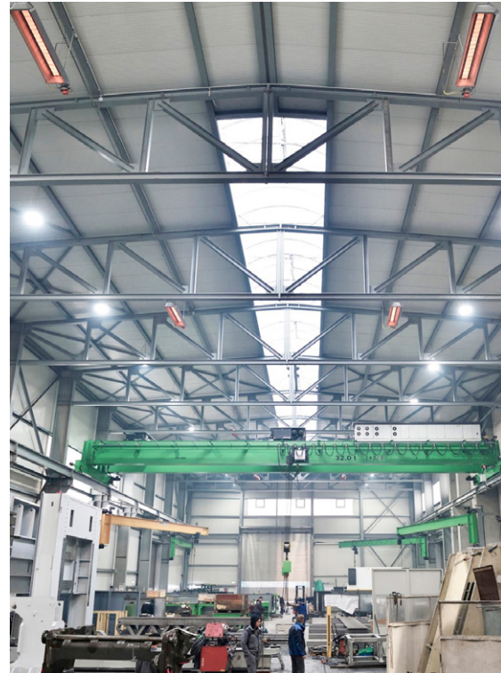
Abbildung 7: Fertigungs-/Montagehalle mit Hellstrahlern (Modell Schwank supraSchwank)
