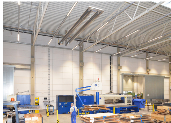
Abbildung 17: Dunkelstrahler in Fertigungshalle, Gerät mit geometrisch optimiertem, 10-fach facettiertem Reflektorprofil
