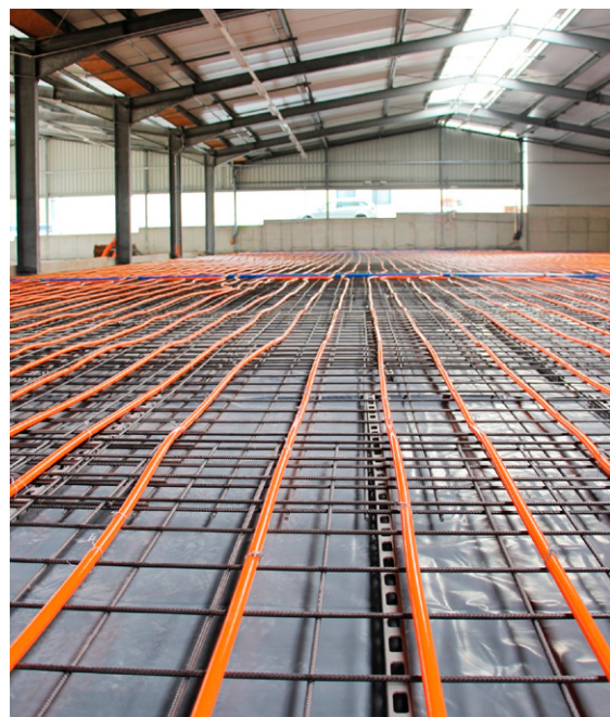
Abbildung 16: Einbau einer Industriefußbodenheizung: Heizrohre an Armierung fixiert
