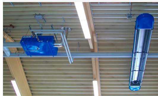
Abbildung 11: Dunkelstrahler mit Abgas-Wasser-Wärmeübertrager; oben: Prinzipdarstellung; unten: beispielhaftes Produktbild (Modell Kübler Optima und Kübler O.P.U.S. X) bis Vor-/Rücklaufleitung Heizmedium
