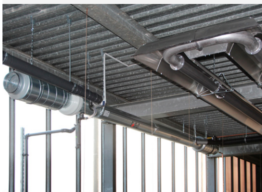
Abbildung 10: Dunkelstrahler mit Abgas-Luft-Wärmeübertrager, oben: Prinzipdarstellung, unten: beispielhaftes Produktbild (Modell GoGaS Trigomax)
