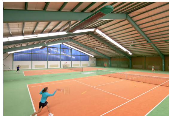
Abbildung 19: Sporthallenbeheizung mit deckenmontierten Strahlungsheizungen, oben: Paneel-Deckenstrahlheizung für Sport-, Veranstaltungs- und Mehrzweckhallen (Modell Frenger S 85), unten: Dunkelstrahler in ballwurfsicherer Ausführung
