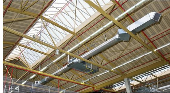
Abbildung 13: Warmluftherzeuger mit Thermovent-Mischluftverteiler zur aktiven Beimischung von Raumluft in den Ausblasstrahl
