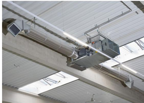
Abbildung 16: Warmlüfterzeuger mit Außenluftanschluss über Dach und Raumlufteinlass für Um-, Misch- und Außenluftbetrieb
