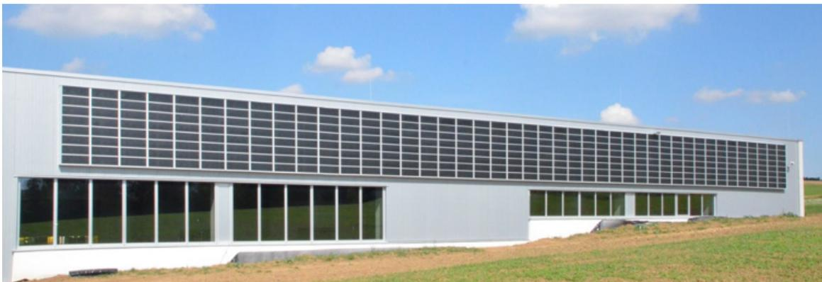
Abbildung 8: Hallenwand mit Solar-Luft-Kollektor, System LUBI Wall: offener Kollektor mit perforierter transparenter Abdeckung für Außenluftbetrieb
